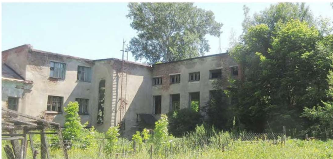
Фото 10. Северо-западный и западный дворовые фасады лит. А 1
