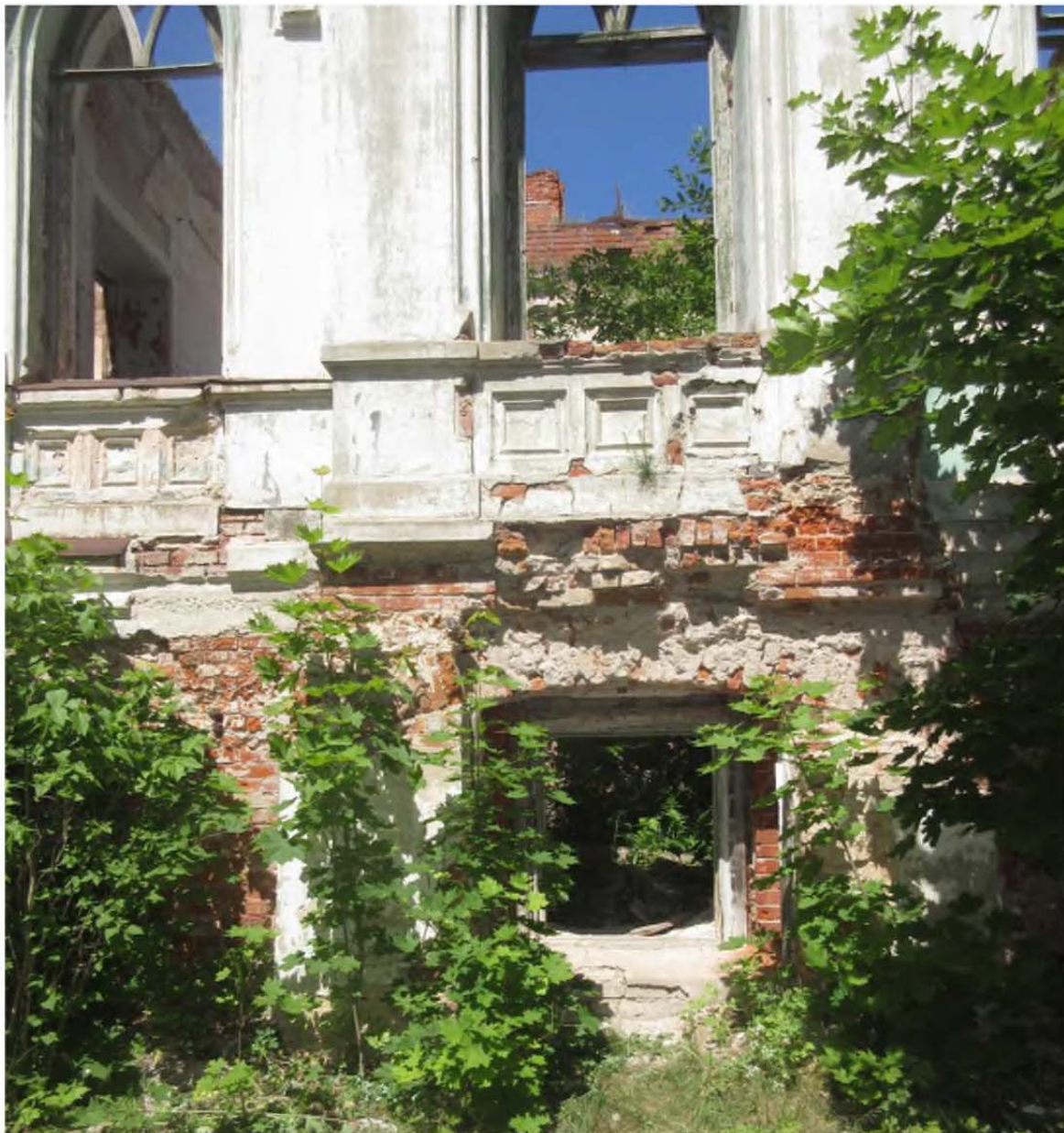
Фото 6. Фрагмент юго-восточного фасада лит. А
