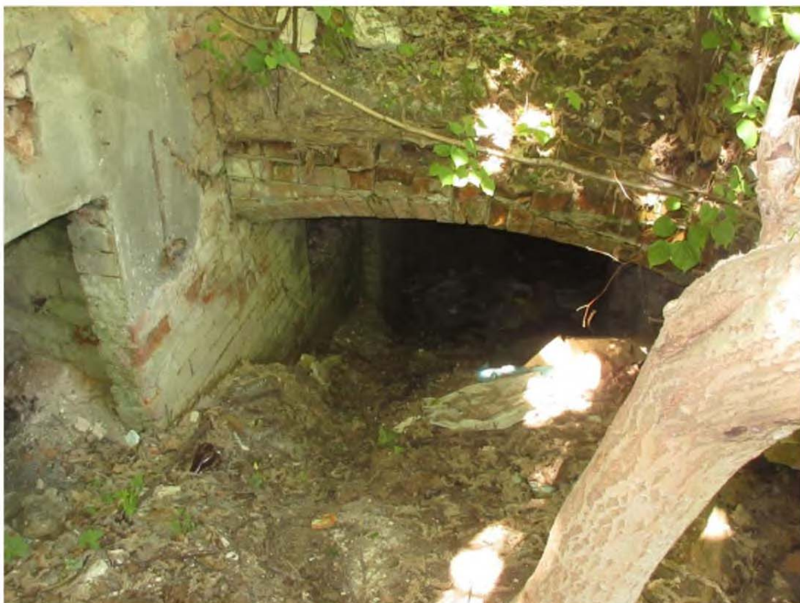
Фото8. Фрагмент юго-западного фасада лит. А. Вход в подвал.
