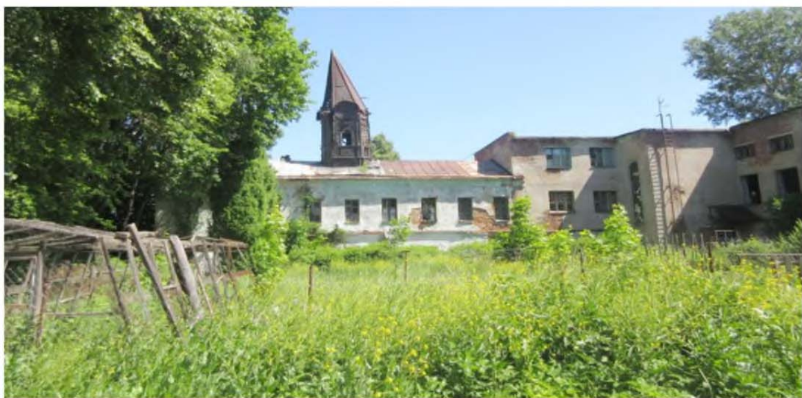
Фото 12. Северо-западный фасад лит. А2
