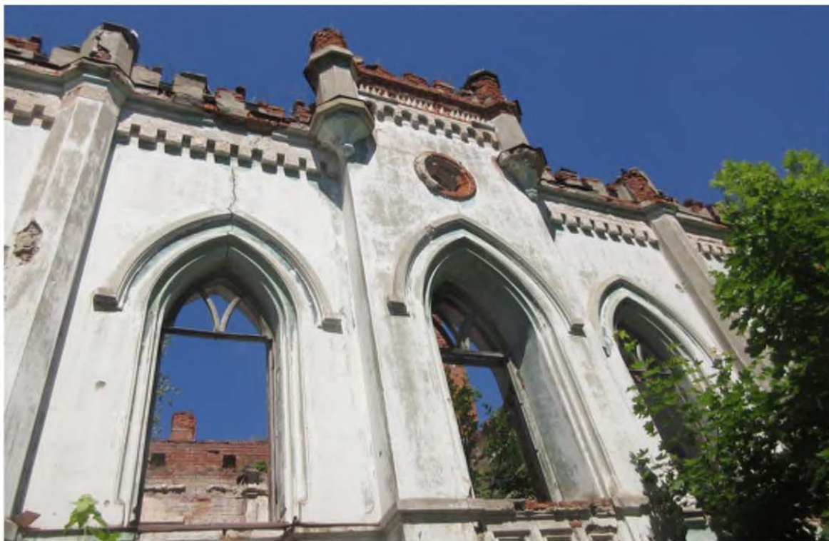
Фото 4. Фрагмент юго-восточного фасада лит. А
