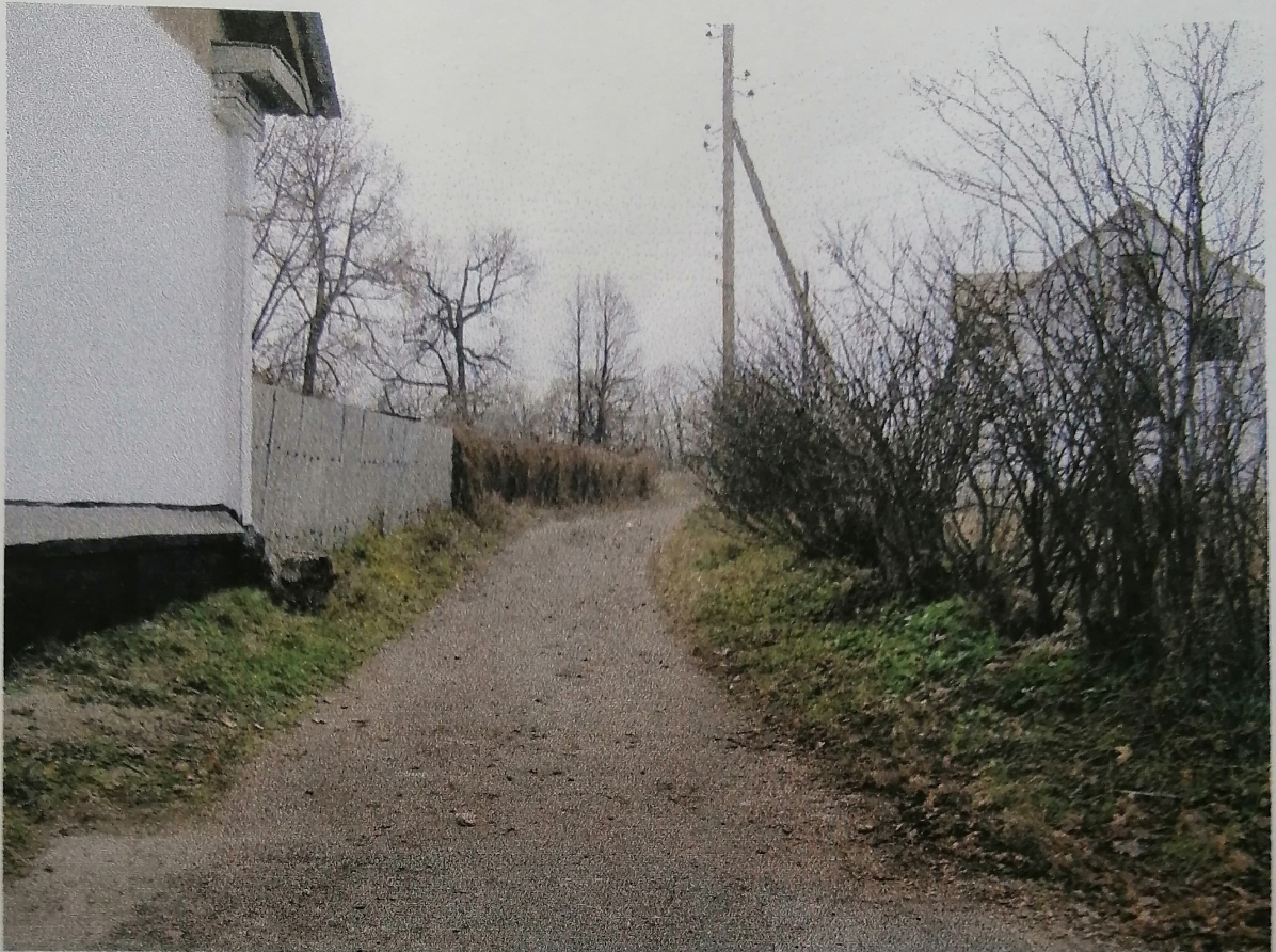
«Дача Башкирцева», северо-западная граница, вид с северо-востока Фото: Домбровский А.А., ноябрь 2005 г.
