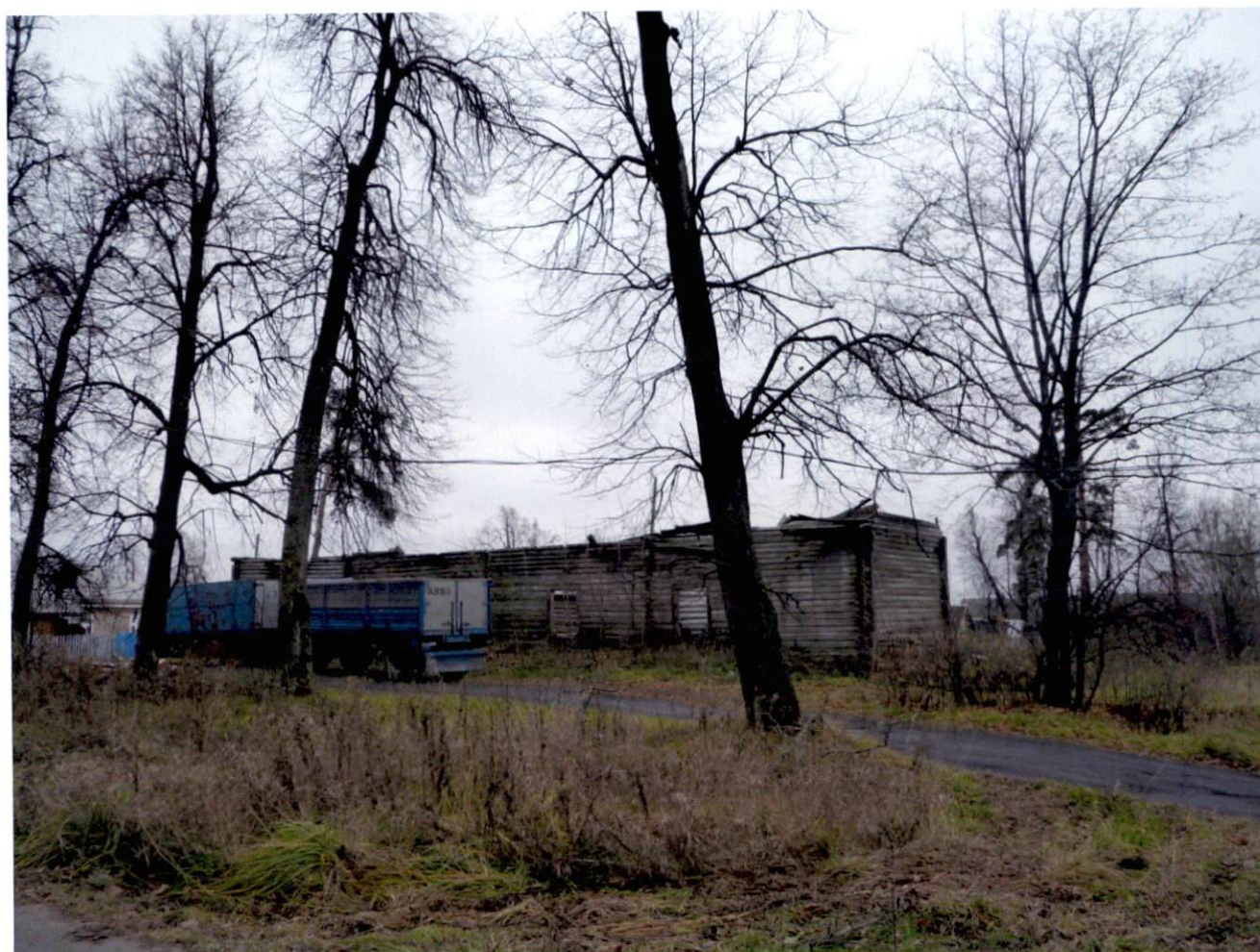
Вид с северо-запада на лабаз
