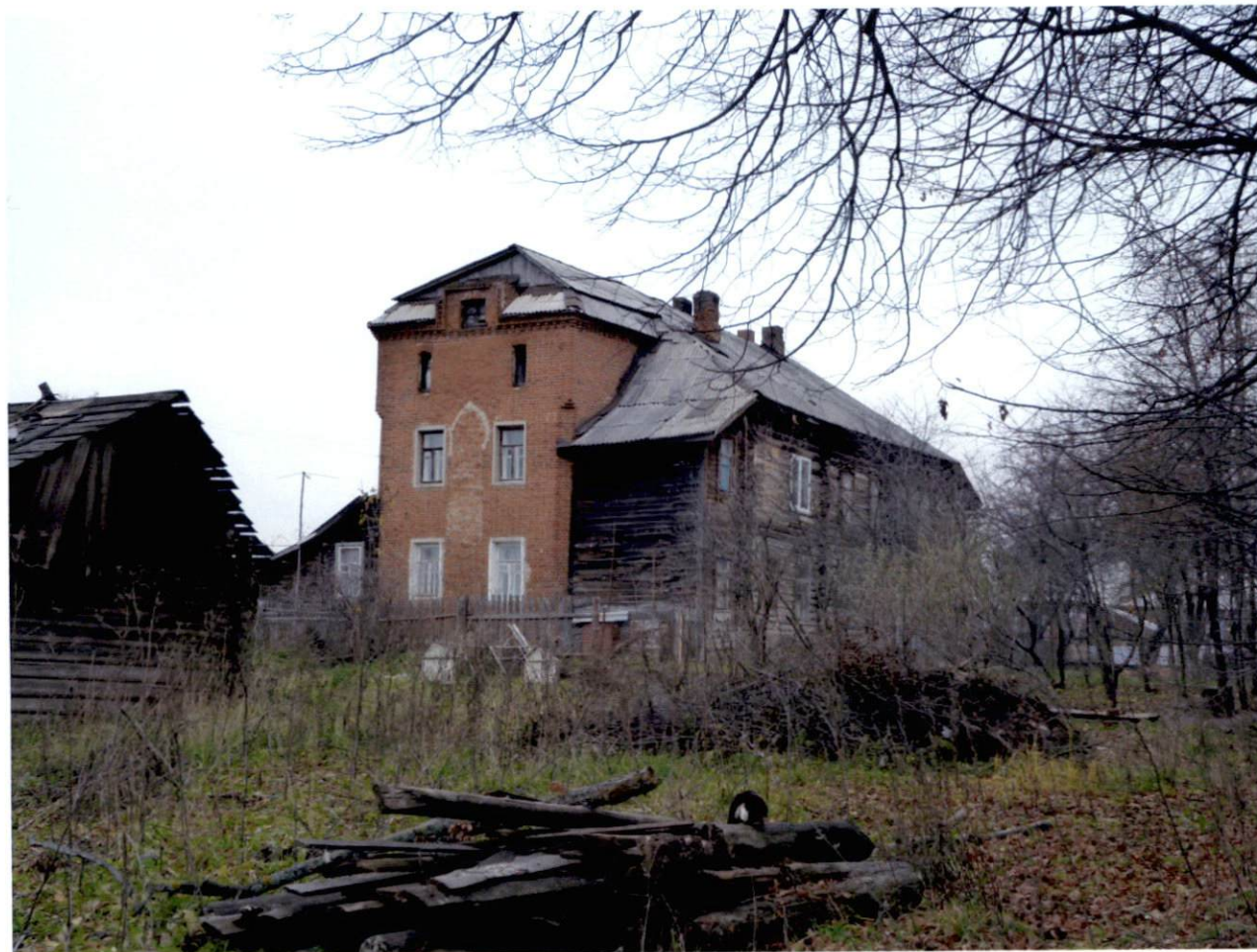
Вид на водонапорную башню с севера
