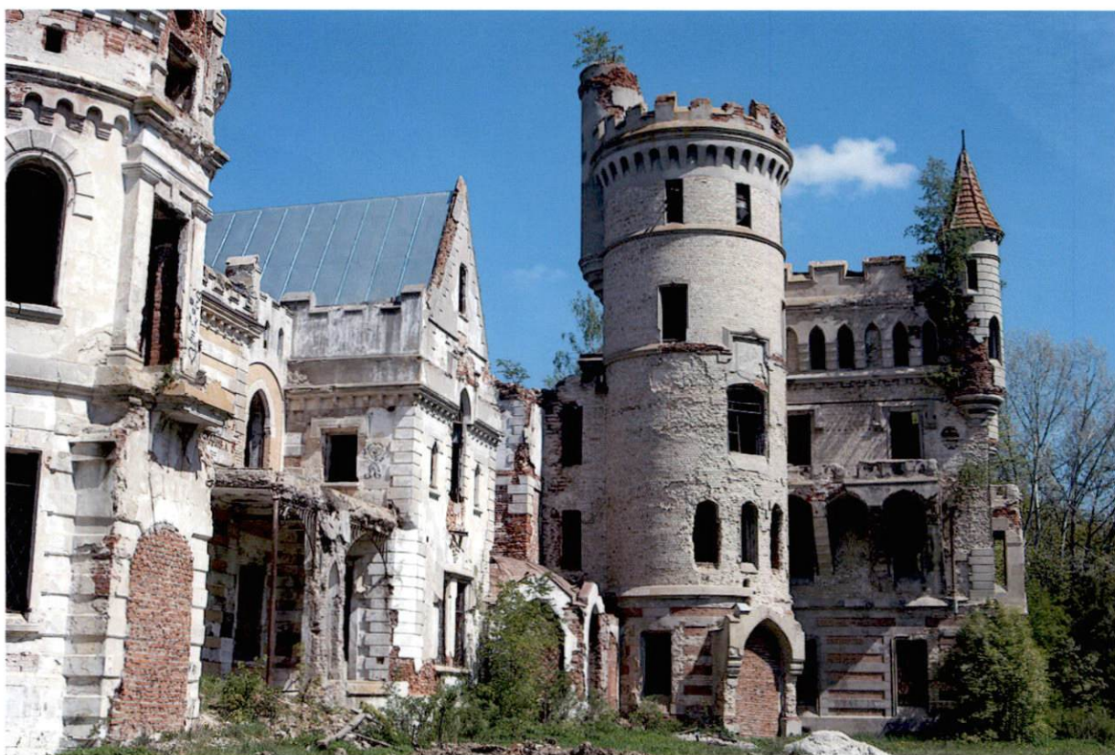
Вид на западный фасад дворца
