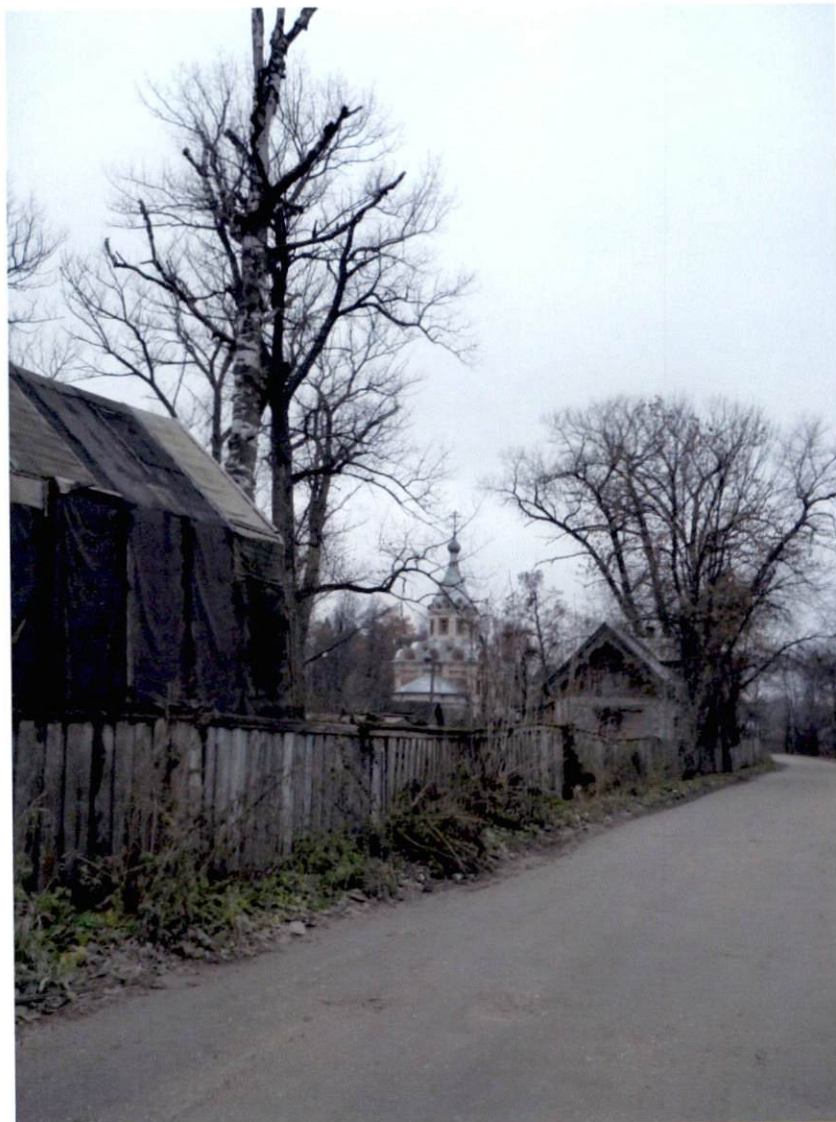
Вид на церковную сторожку и церковь «Царицы Александры» с северо-востока
