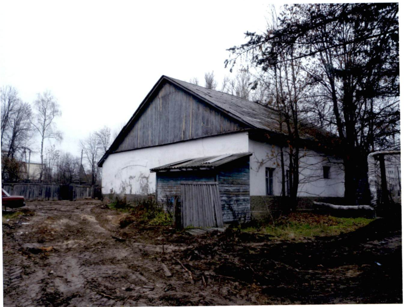
Вид на баню с северо-запада
