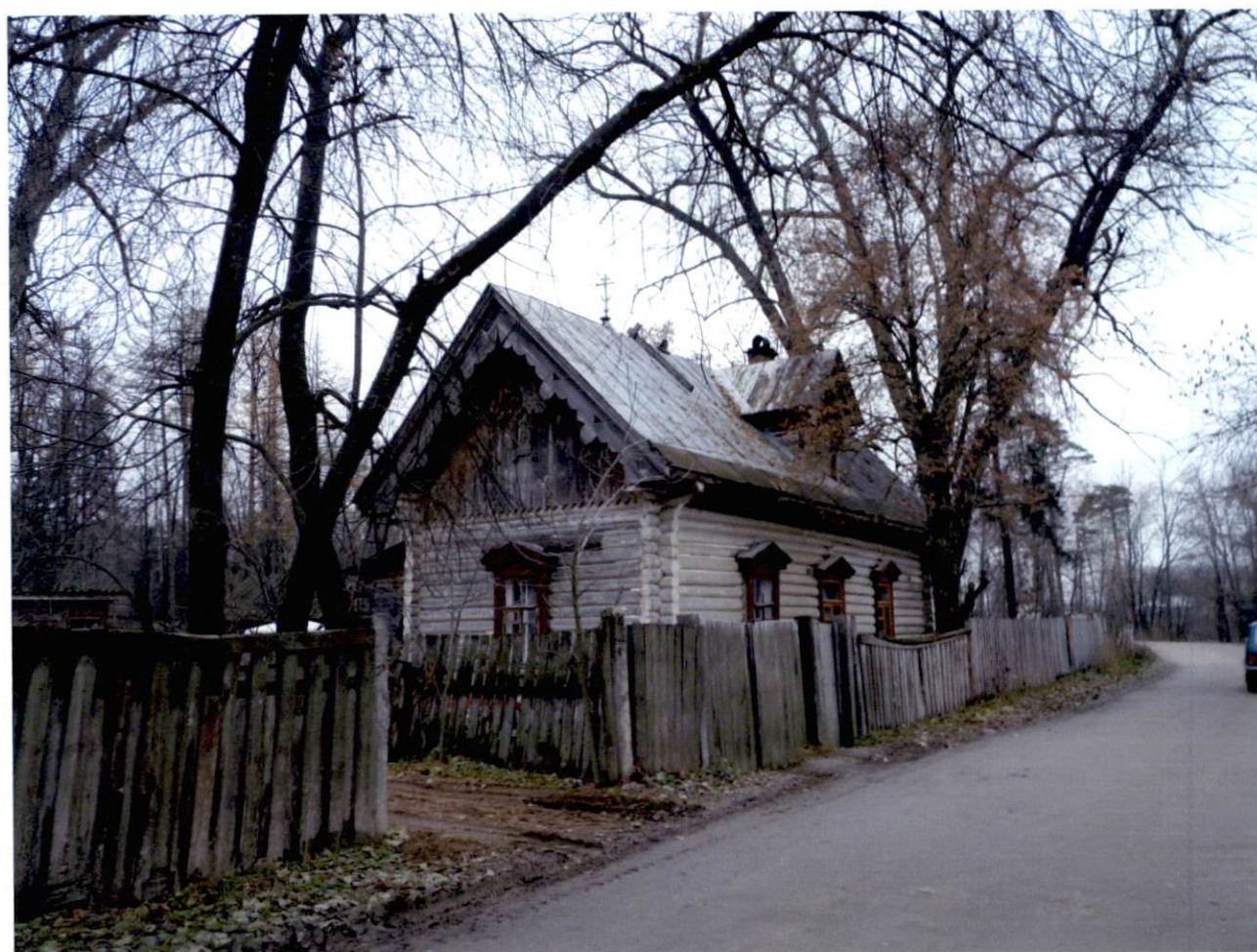
Вид на церковную сторожку с северо-востока
