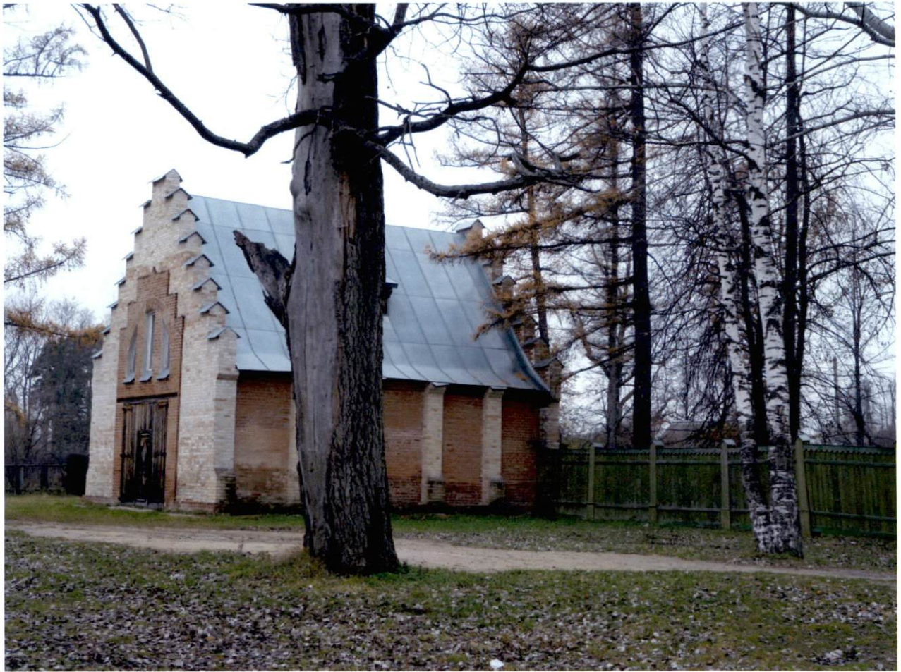
Вид с востока на лодочный павильон
