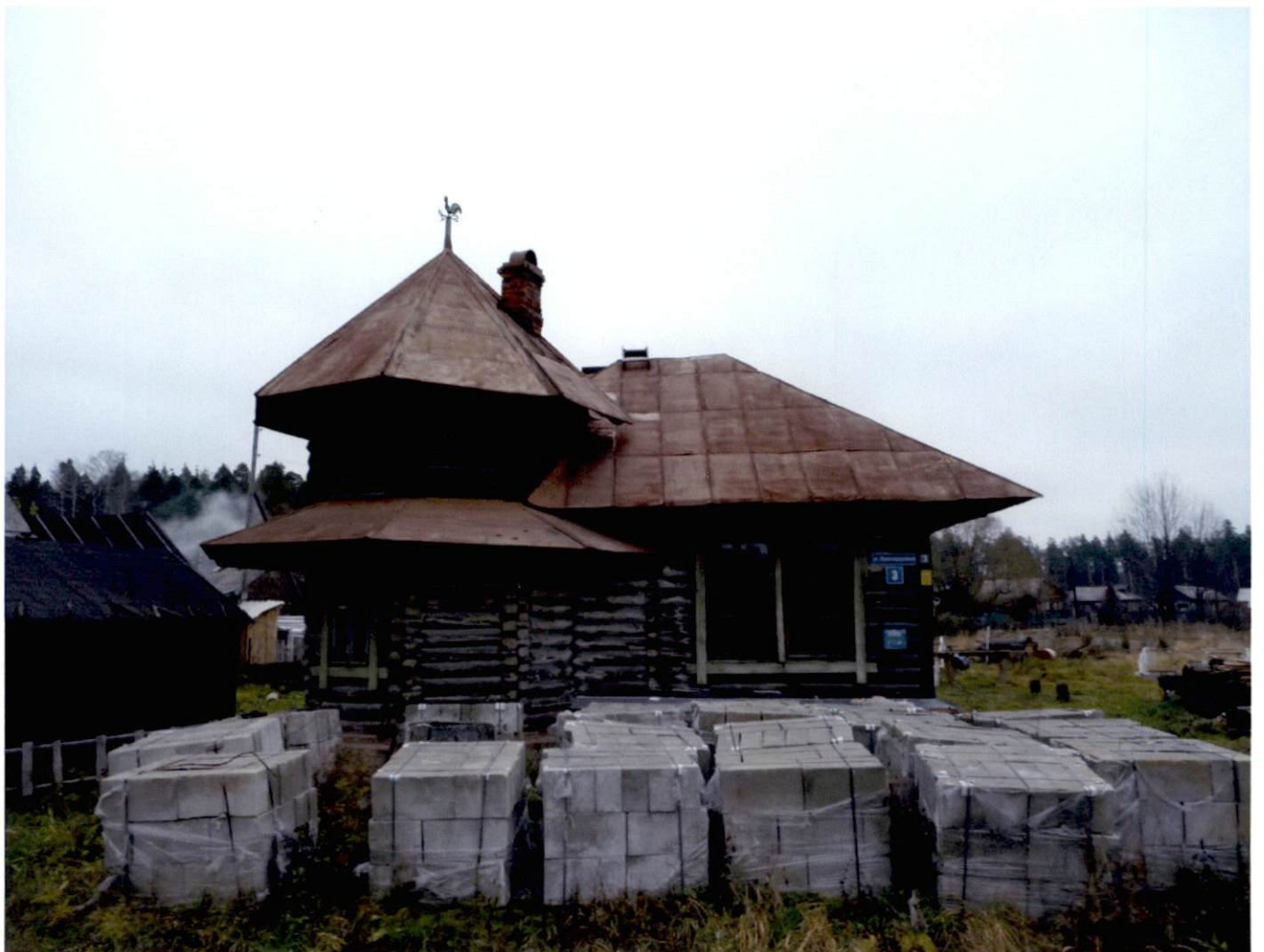
Вид с востока на сторожку лесника
