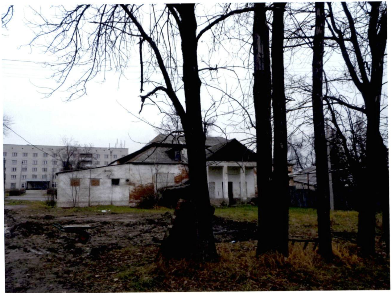
Вид на здание магазина с юга
