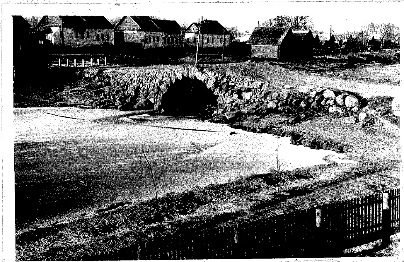
АРОЧНЫЙ МОСТ ПОСЛЕ РЕСТАВРАЦИИ с. Грузины
