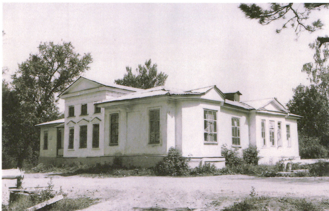
1. Общий вид здания с юго-запада. Фото 1992 г.
