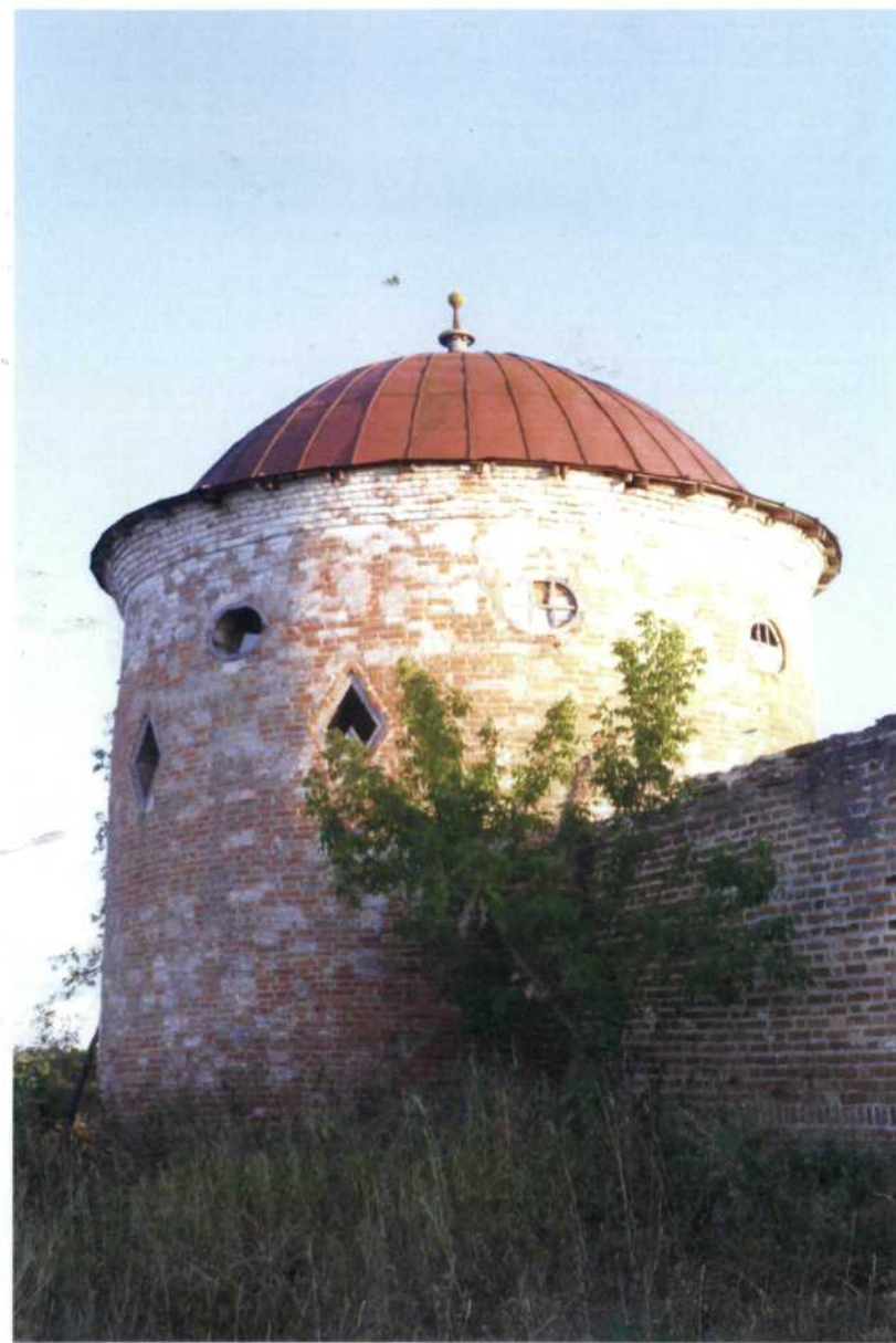
Фото 2. Ансамбль Сабуровской крепости: б) Четыре башни. XVIII в. 12.06.2010 г. Круглая юго-восточная башня. Вид с северо-востока.
