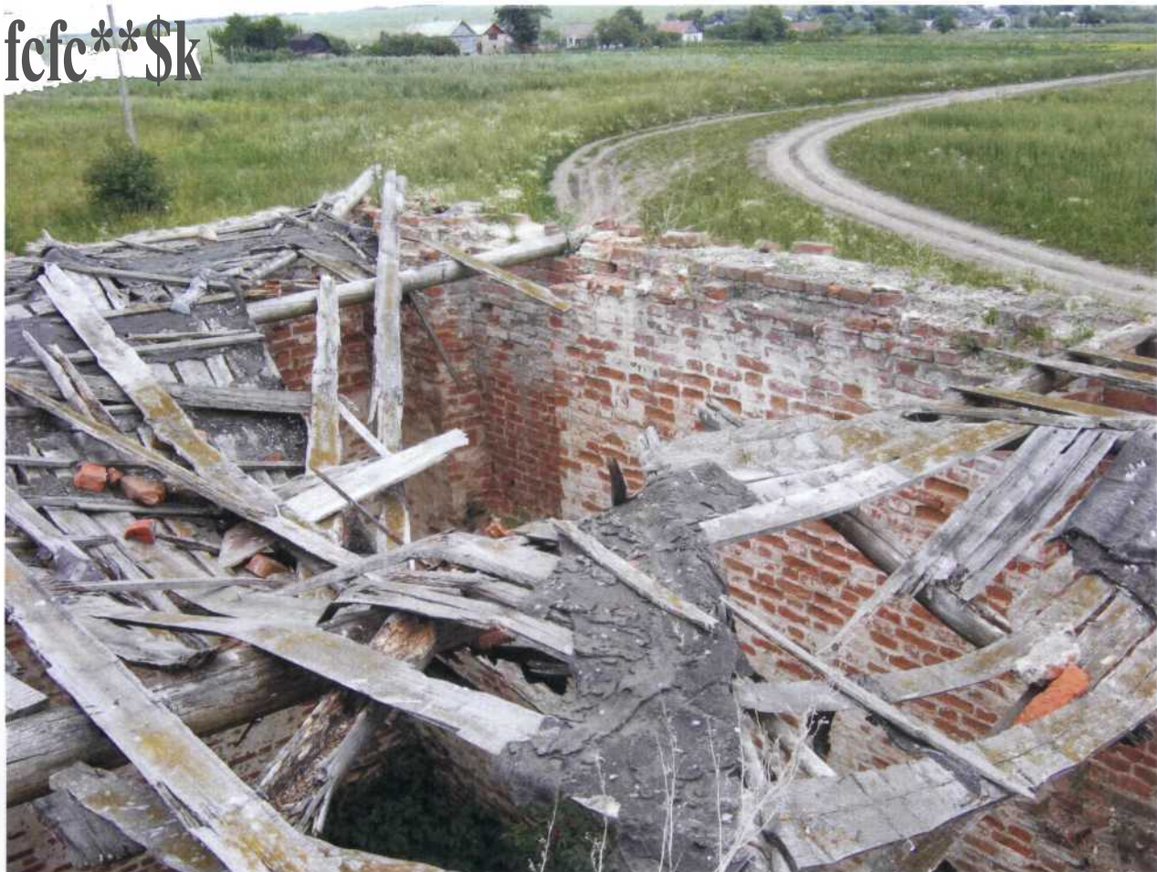
Фото 5. Ансамбль Сабуровской крепости: д) Амбар. XVIII в. 12.06.2010 г. Вид с юго-запада.
