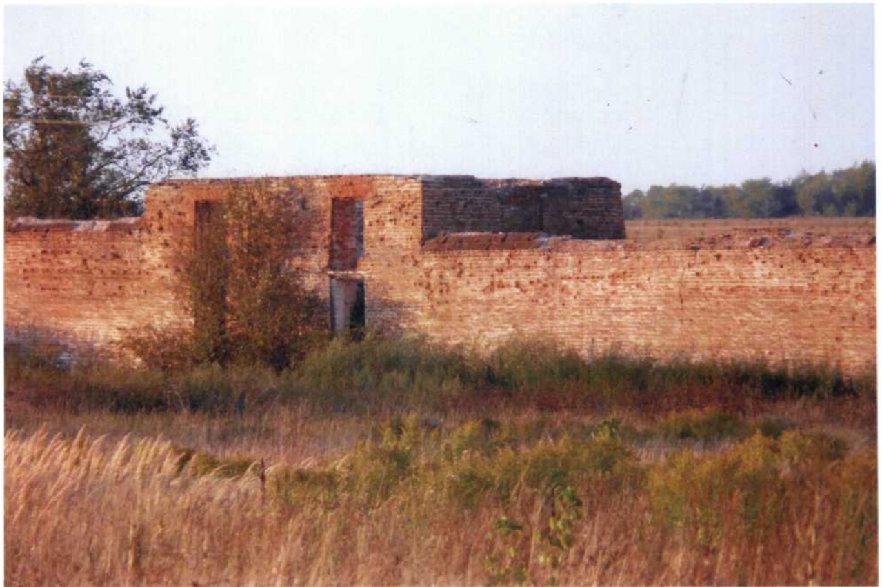
Фото 4. Ансамбль Сабуровской крепости: д) Амбар. XVIII в. 12.06.2010 г. Вид с юго-запада.
