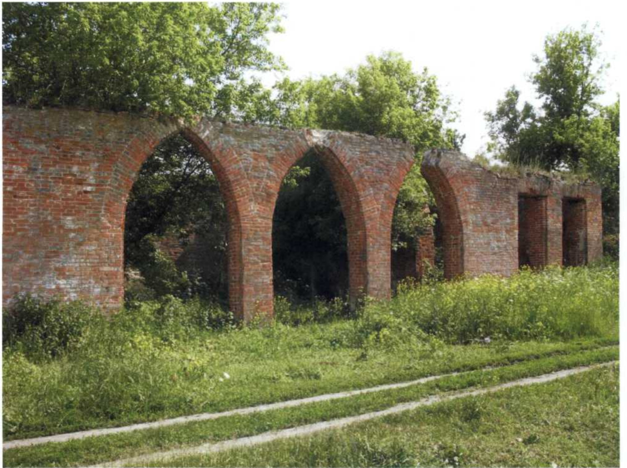
Фото 3. Ансамбль Сабуровской крепости: в) Здание театра. XVIII в. 12.06.2010 г. Вид с северо-востока.
