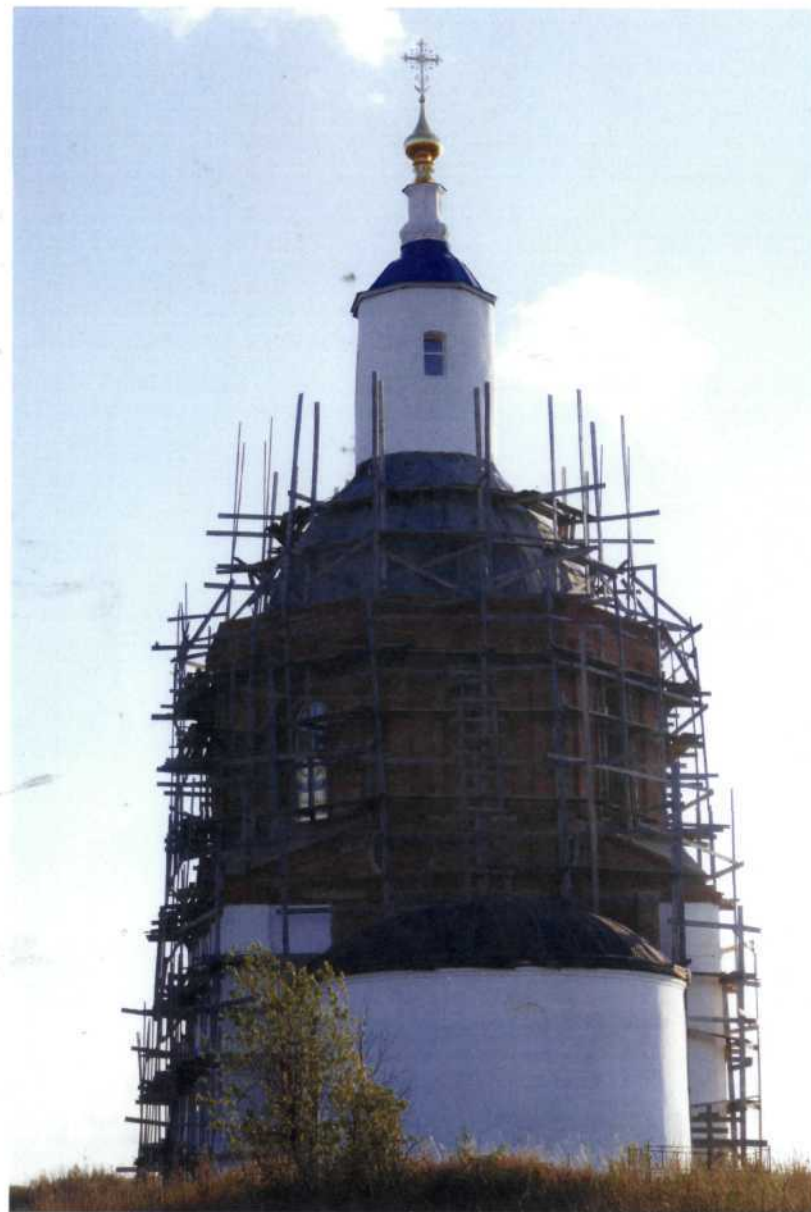
Фото 8. Ансамбль Сабуровской крепости: г) Церковь Михаила Архангела. XVIII в. 12.06.2010 г. Апсида. Вид с востока.
