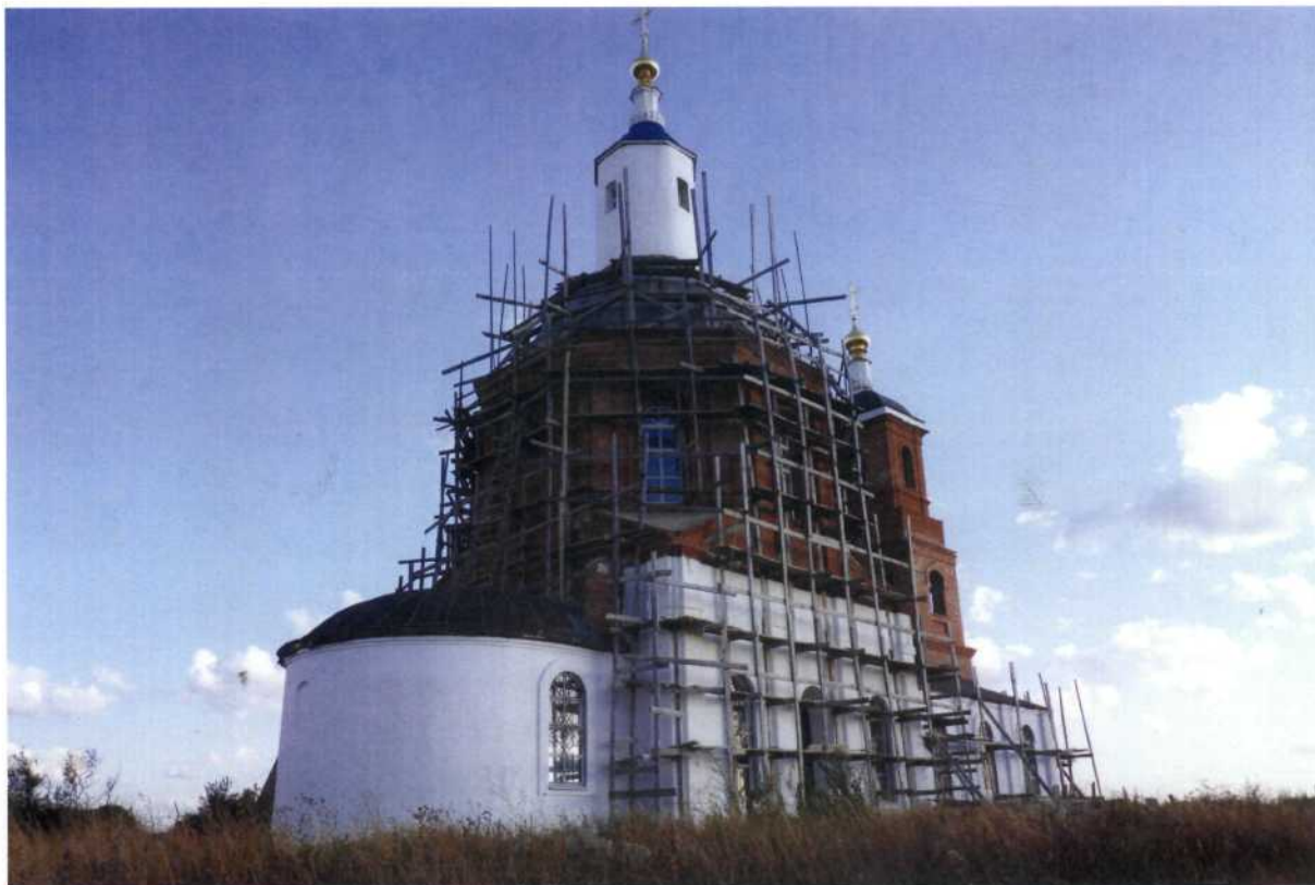
Фото 5. Ансамбль Сабуровской крепости: г) Церковь Михаила Архангела. XVIII в. 12.06.2010 г. Вид с северо-востока.
